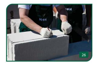
Чтобы распил получился наиболее точным, необходимо сделать разметку линии резки карандашом на двух сторонах блока - горизонтальной и вертикальной, а также использовать угольник\*. 26 27
