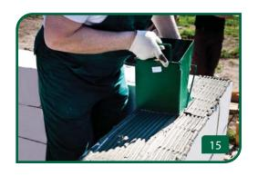
К кладке второго ряда можно приступать после схватывания цементно-песчаного раствора первого ряда (т.е. через 1-2 часа). Кладка начинается с угла. Угловой блок устанавливается с перевязкой шва, что обеспечивает смещение вертикальных швов второго ряда по отношению к вертикальным швам первого ряда на длину не менее ширины блока. В последующем рекомендуется выполнять смещение вертикальных швов очередных рядов по отношению к нижестоящим не менее чем на 10 см.
